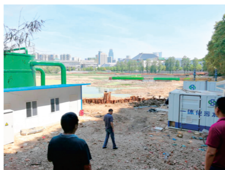
图8 污水设施检查
